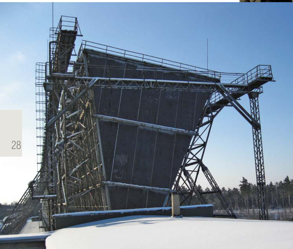
Размеры антенны Иркутского радара НР (слева) составляют 240 м в длину, 12 м в ширину и 20 м в высоту
